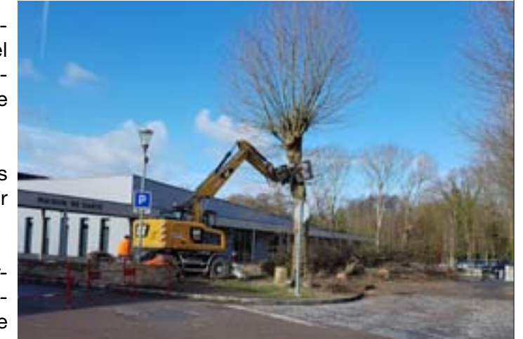
DÉBUT DES TRAVAUX À LA MAISON DE SANTÉ
