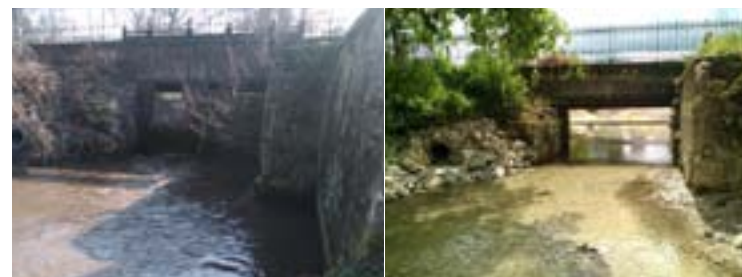
VANNAGE DE SUIPPES VUE DE L'AVANT TRAVAUX
