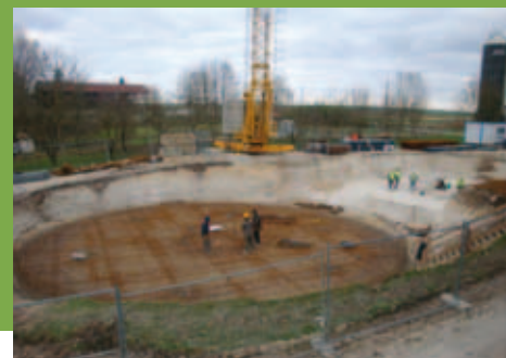
Préparation du ferrailage du fond des deux principaux bassins de traitement
