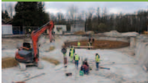
Préparation du ferrailage du fond des deux principaux bassins de traitement
